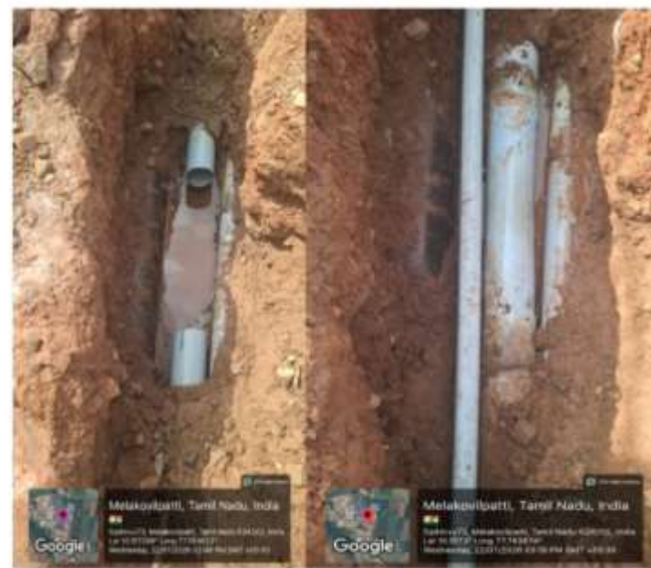
23.07.2026 அன்று 160 mm pvc குழாய் அணைப்பு சரி செய்யப்பட்டு புகைப்படம்
